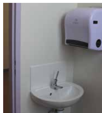
Aménagement d'un bloc sanitaire
